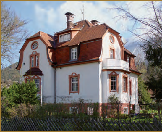
Abb. 4 | Villa Heimat in Partenkirchen, Blick von Südwesten
